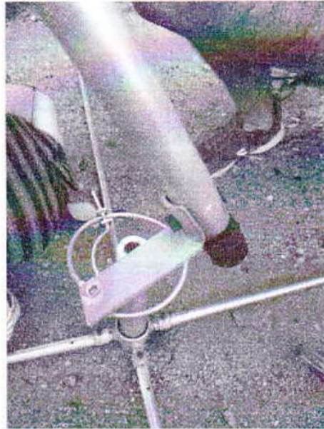
ANTENA REPARADA PROVISORIAMENTE
